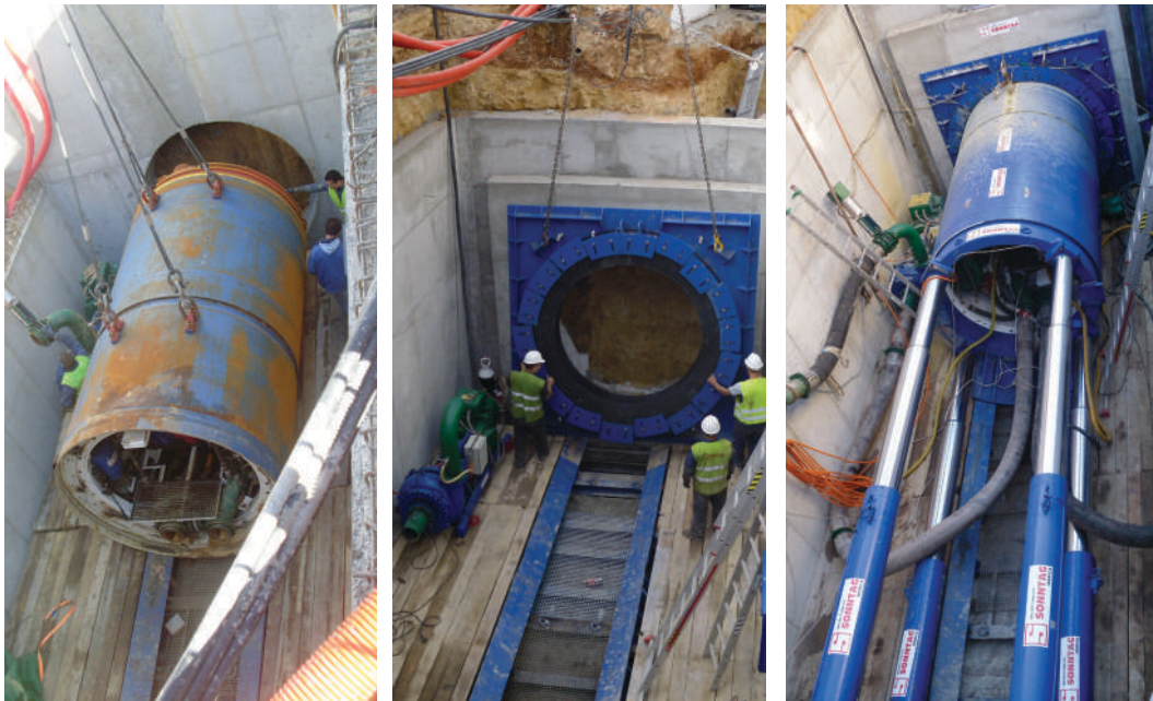
Micro túnel de tubería de hormigón armado de 2.200 mm en roca.
