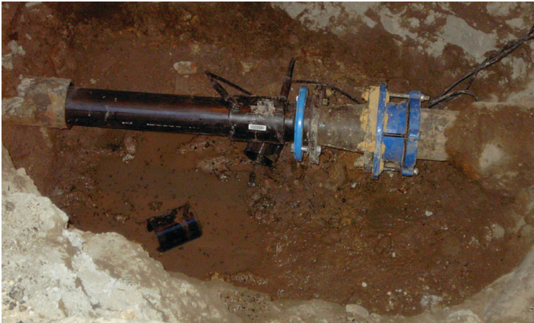
Utilización de la tecnología del Berstlining en una obra.
