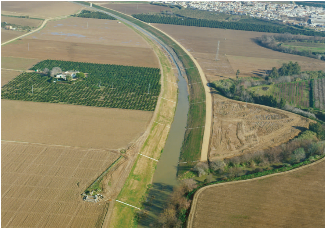
Canalización del arroyo Siete Arroyos. Nuevo cauce de cerca de tres kilómetros para evitar inundaciones.
