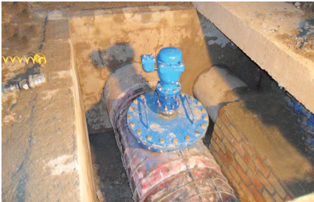
Reparación en ventosa en una tubería de 800 mm de hormigón armado.
