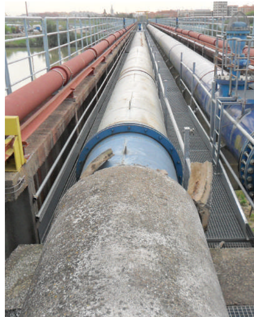
Estado final de la nueva tubería.
