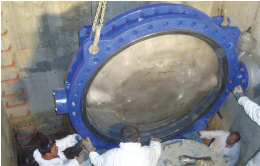
Instalación de una válvula de mariposa de 1.600 mm de diámetro.
