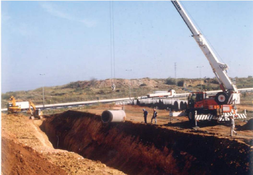
Operación de instalación de un colector de hormigón armado de 800 mm.
