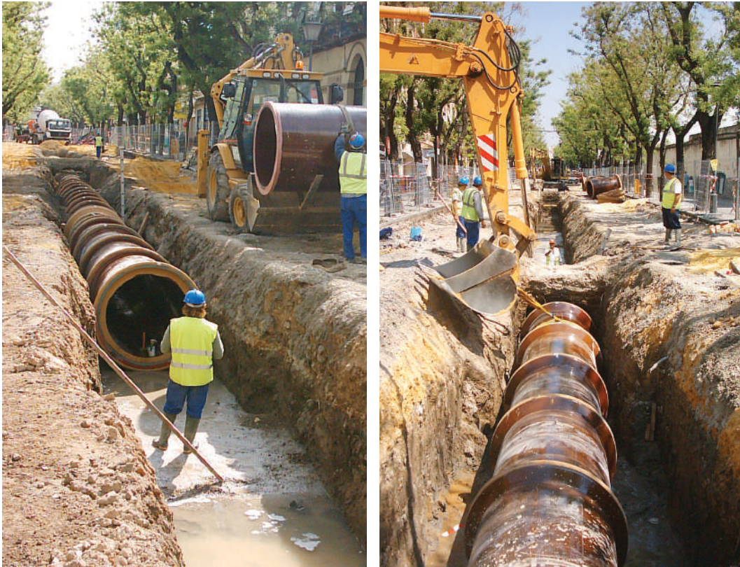
Instalación de tubería de gres vitrificado de 1.200 mm interior para saneamiento.
