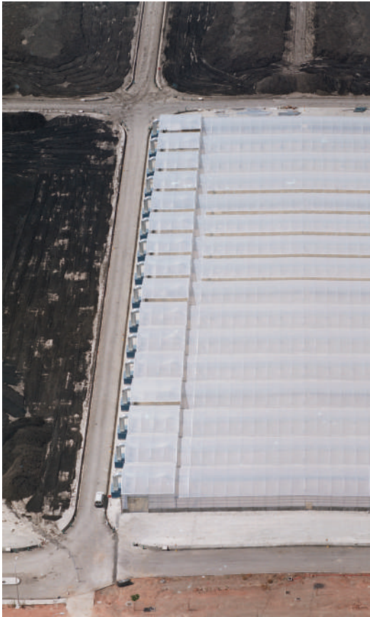
Instalación para secado de fangos de más de 8.000 m 2 .
