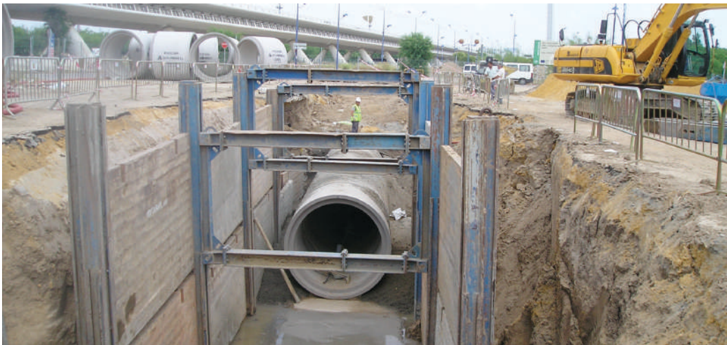
Reparación en un colector de aguas residuales.
