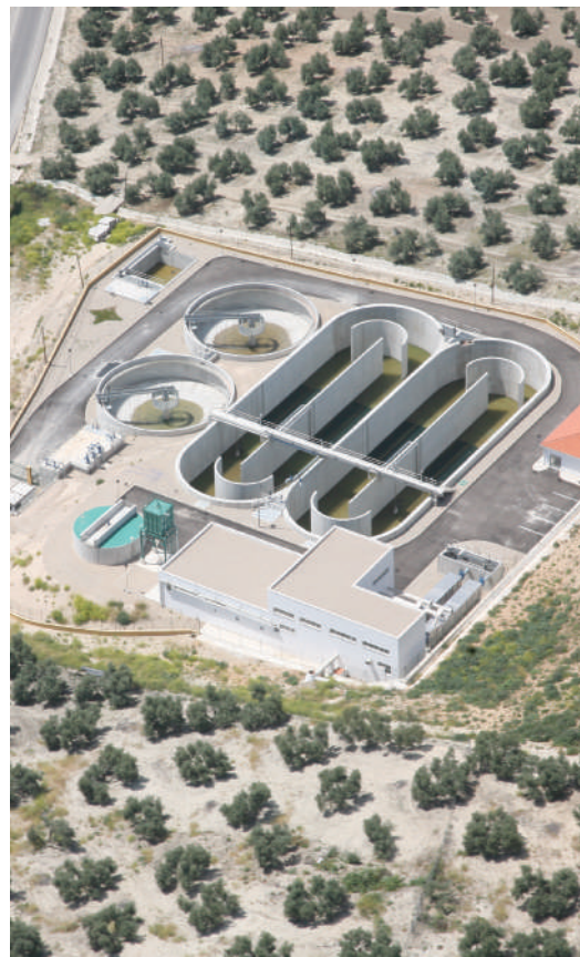
Depuradora de Baeza (Jaén), que da servicio a una población de 25.000 habitantes, con un caudal de 6.550 m 3 /día.
